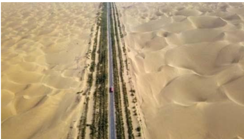
Figure 7 : Taklamakan Desert Highway traversant le désert ( source : Xinjiang Government )
